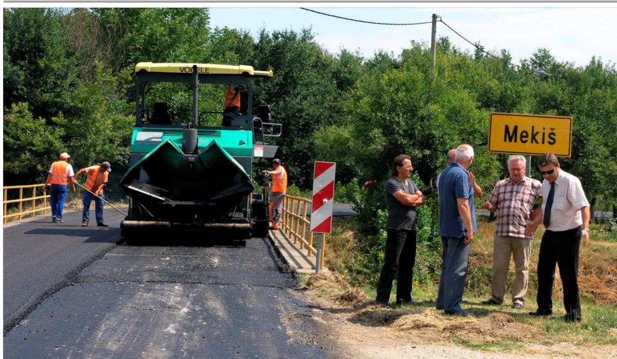
Obnova asfaltnog sloja u Mekišu 2011. godine.
