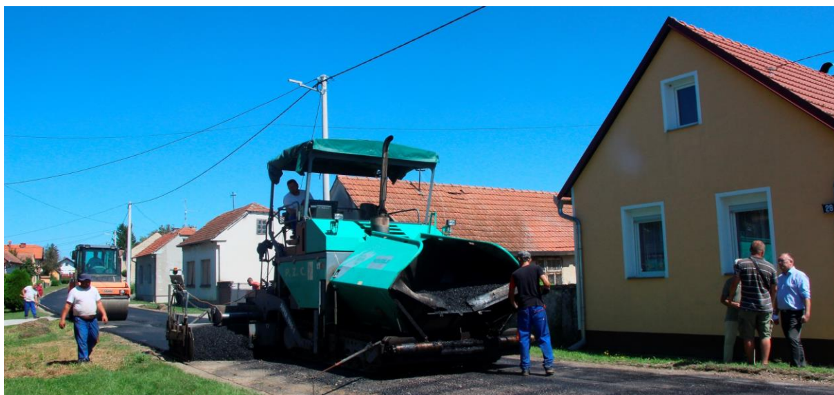
Postavljanje novog sloja asfalta u Staroj cirkvi 2020. godine.
