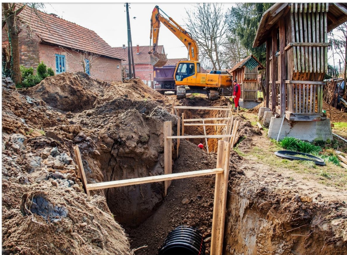
Polaganje kanalizacijskih cijevi u Koprivlju 2008. godine
