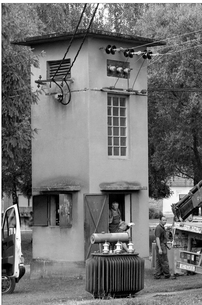
Ugradnja novog transformatora
